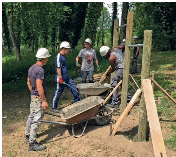
Chantier d'insertion, aménagement parcours de santé.
