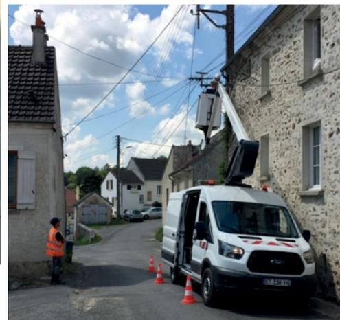
▲ Installation en aérien à Crogis avec boîtier de raccordement de la fibre à destination des habitations, la connexion de la fibre se fait par soudure avec écran de contrôle ►
