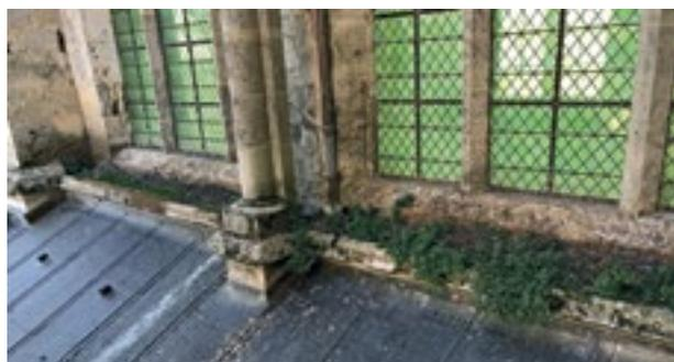
► **L'Association pour la Sauvegarde de l'Abbatiale a bénéficié de l'accès offert par l'échafaudage du vitrailleur pour réaliser le nettoyage des chéneaux et gouttières complètement obstrués par les poussières accumulées et les fientes de pigeons. De gros dégâts étaient à craindre lors d'une forte gelée menaçant de faire éclater le système d'évacuation des eaux de pluie restauré à l'occasion des importants travaux de toiture de 2008-2012.**
