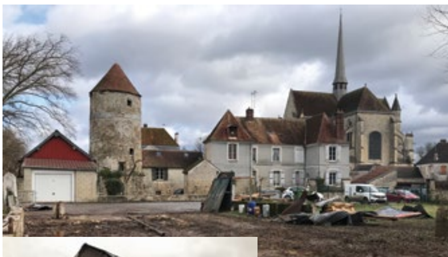
◀▲ Déblaiement de la parcelle rue du Jeu d'Arc sur laquelle se trouvait un ancien hangar technique qui a été démoli.
