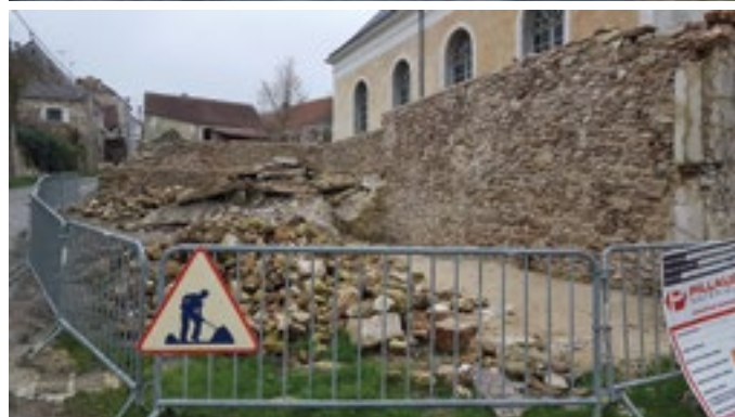
▲ Démolition et travaux à Monneaux, à côté du temple, réalisation d'un parking..
