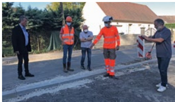
Fin de chantier, en présence des employés de la société RVM, le maire Jean-Paul Bergault (à gauche), l'ancien maire Jean-Paul Clerbois (au centre) et M. Lepigeon maître d'œuvre.
